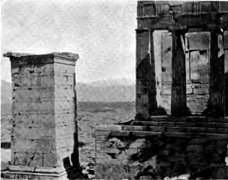
37. Nordwestecke der Pinakothek.
